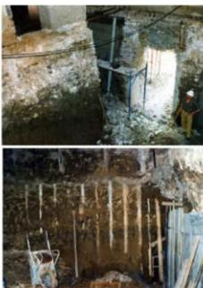
Particolare dello scavo e di alcuni micropali inseriti nel terreno. (foto C. Visintini)
