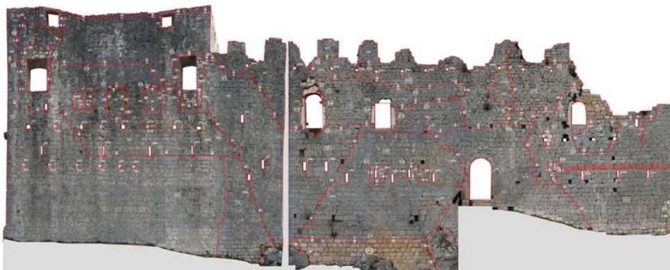
*Fig 9.20 Fotopiano relativo all'ambito della cinta muraria settore C2 (vista esterna) con identificazione delle unità stratigrafiche*
