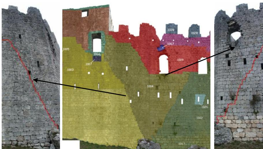
*Fig. 9.23 particolare del settore C2 con individuate le diverse azioni costruttive.*
