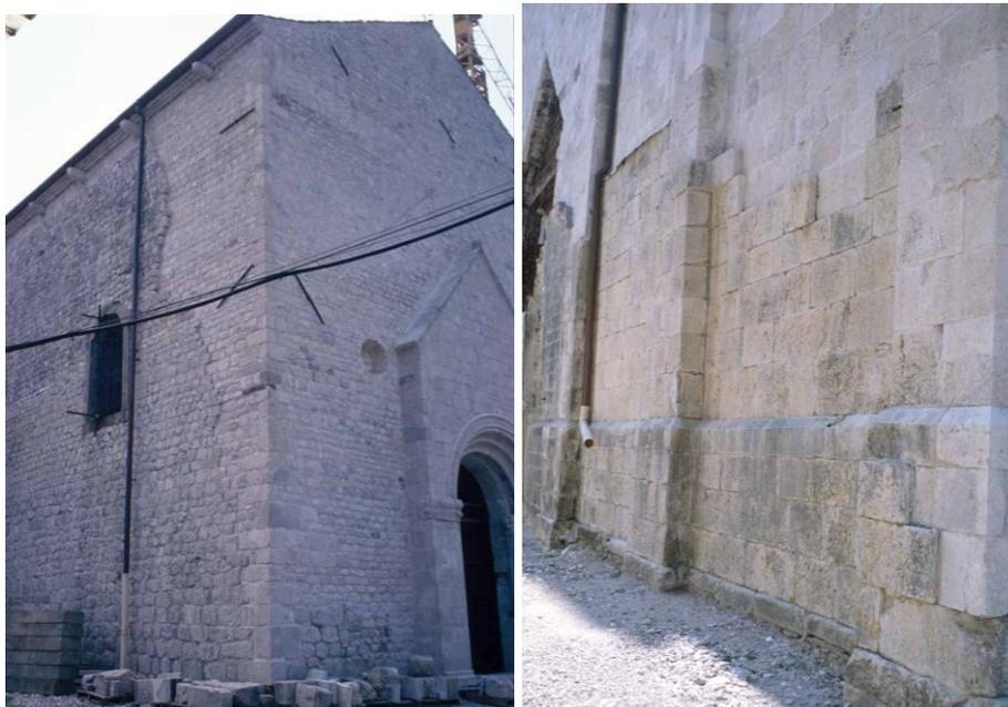
*Fig. 2.23 Venzone (UD): Immagine in corrispondenza dell'angolo nord-est del Duomo con evidente lo scarto tra la parte nuova e quella vecchia (foto A. Quendolo 1995)*
