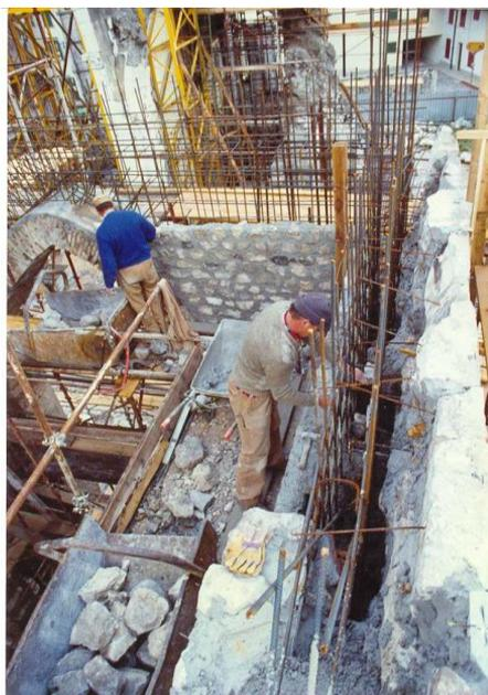
*Fig. 2.25 Venzone (UD): Immagine dell'armatura del nucleo murario della nuova muratura (foto L. Fantoni 1995)*
