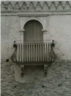
Terrazzino con basamento e mensole in pietra, parapetto in lame di ferro a lira; porta di accesso al terrazzino archivoltata con stipiti in monoliti sagomati di pietra
