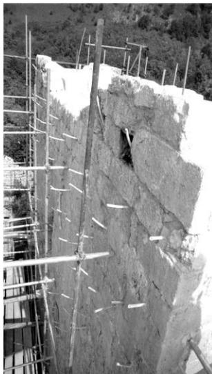
Palazzetto: particolare della muratura con i tubicini per le iniezioni della miscela a base cementizia all'interno del nucleo (foto ASU)
