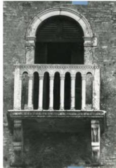
Terrazzino con basamento, mensole e parapetto in pietra; il parapetto in particolare è costituito da una teoria di colonnine con capitello ionico. porta di accesso al terrazzino archivoltata con stipiti in monoliti sagomati di pietra
