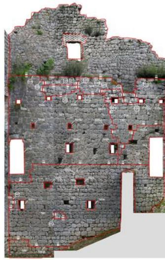
*Fig 9.19 Fotopiano relativo all'ambito della cinta muraria settore D1 vista interna con identificazione delle unità stratigrafiche.*
