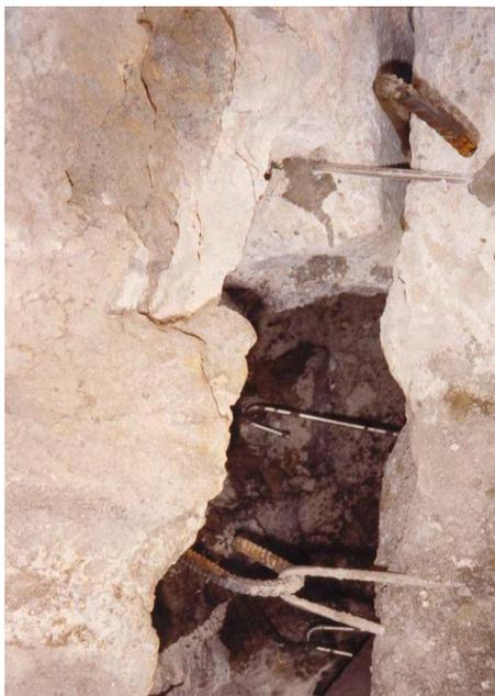
*Fig. 2.24 Venzone (UD): Particolare delle "corde" in acciaio inossidabile legate alla parte posteriore della pietra per ancorarla al nucleo murario (foto L. Fantoni 1995)*
