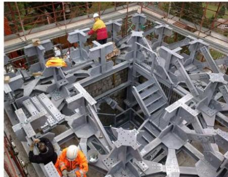
La struttura in acciaio inserita all'interno della torre
