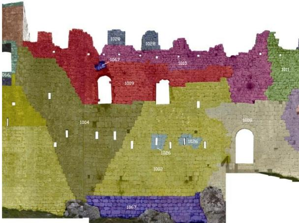
Confrontando la parte interna con quella esterna del muro nel settore C2-C2, si rileva la differenza di apparecchiatura muraria che rimane uguale sul lato esterno, rispetto all'attività 1002, mentre cambia su quello interno (attività 1026, 1008, 1037, 1031 e le due aperture archivolte realizzate in rottura). Le finestre del secondo ordine sono inserite in rottura, testimoniando modificazioni d'uso della parte interna alla cinta stessa.
