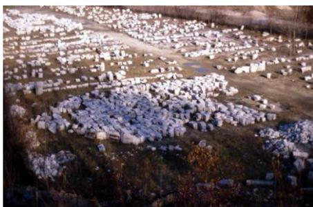
*Fig. 2.21 Venzone (UD): il "campo delle pietre" con la ricomposizione a terra della facciata principale del Duomo (foto A. Quendolo 1995)*
