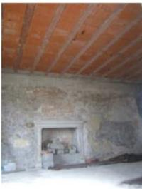
Particolare di uno degli ambienti al primo piano con il solaio sostituito in latero-cemento
