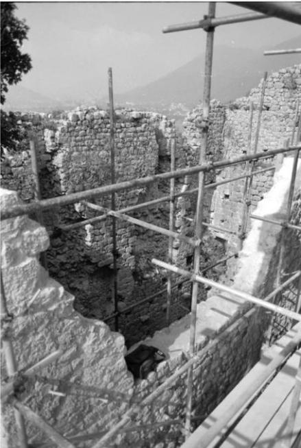
Parete interna del palazzetto durante la fase di ricostruzione delle porzione crollata (foto ASU)
