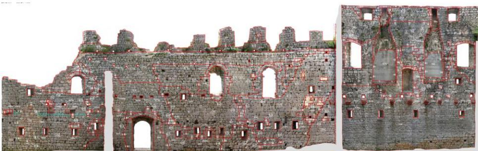
*Fig 9.21 Fotopiano relativo all'ambito della cinta muraria settore D2 (Vista interna) con identificazione delle unità stratigrafiche*
