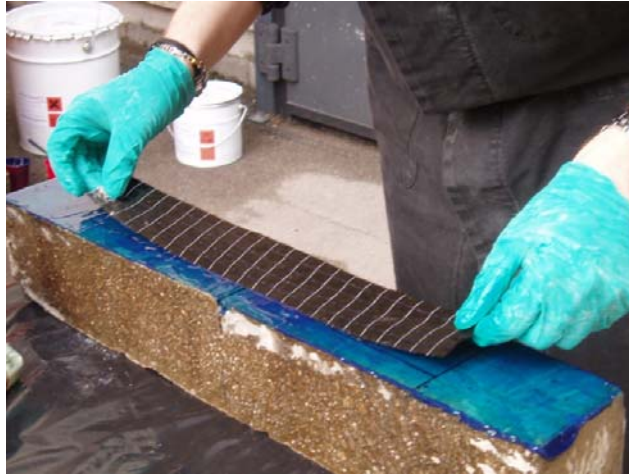
Fig. 84 Incollaggio fibre
