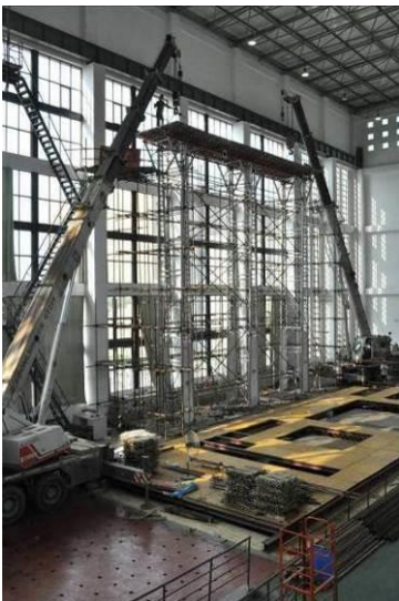
m) Hoisting integrally
