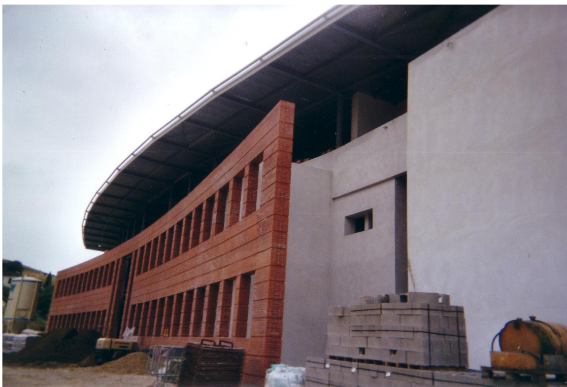
05. Le Chantier du pôle Liorello
