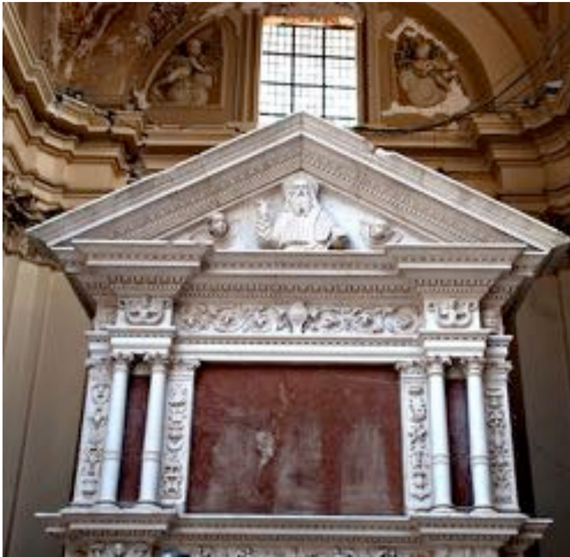
Fig. 364 Girolamo Pittoni, Mausoleo di San Pietro Celestino , L'Aquila, basilica di Santa Maria di Collemaggio, particolare
