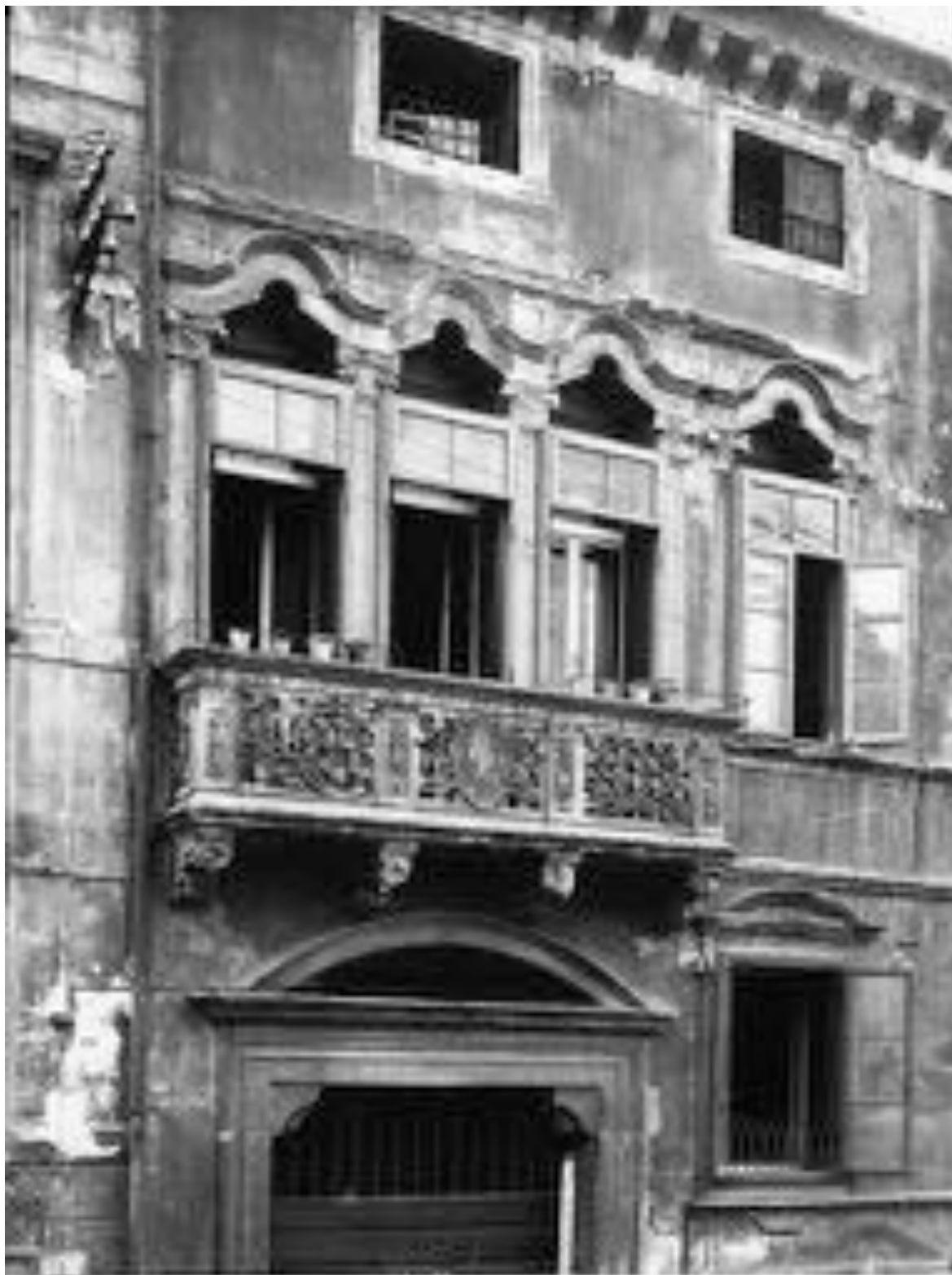
Fig. 349 Palazzetto Vigna , Vicenza, contrà Catena
