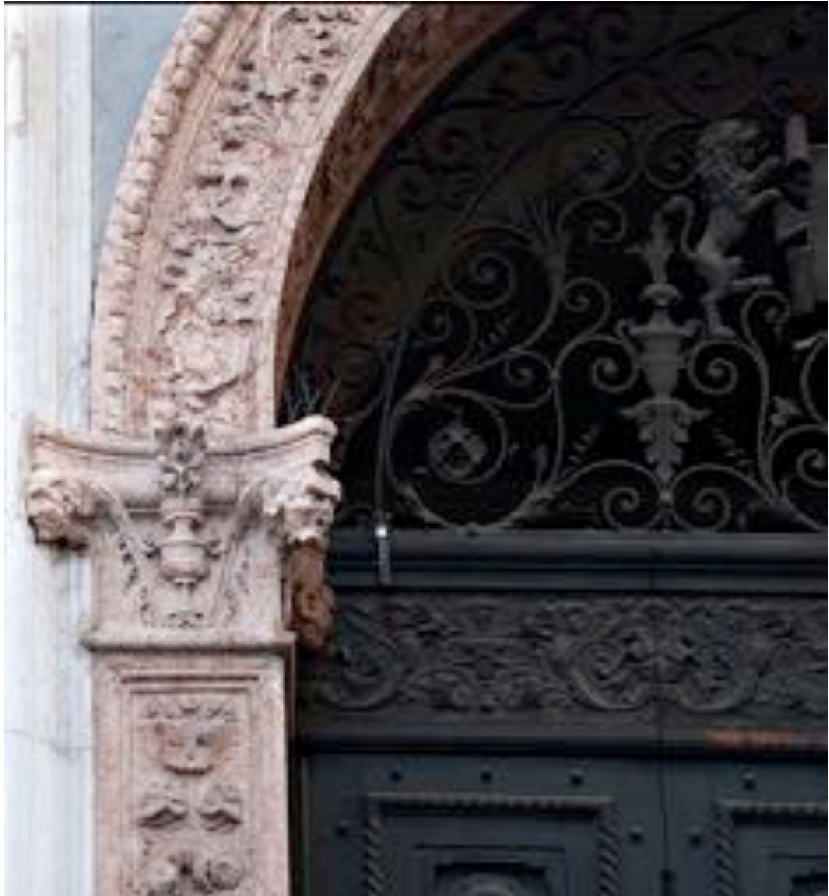
Fig. 226 Portale , Vinceza, contrà Porti, Palazzo Thiene, particolare
