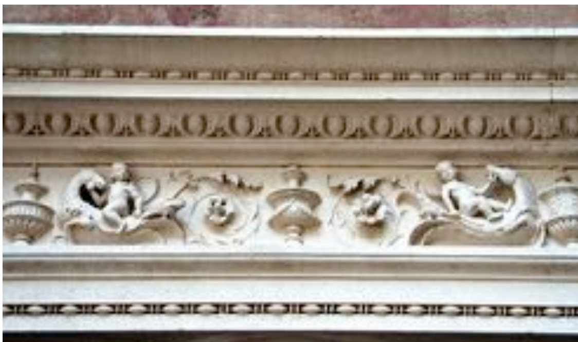
Fig. 366 Girolamo Pittoni, Mausoleo di San Pietro Celestino , L'Aquila, basilica di Santa Maria di Collemaggio, particolare
