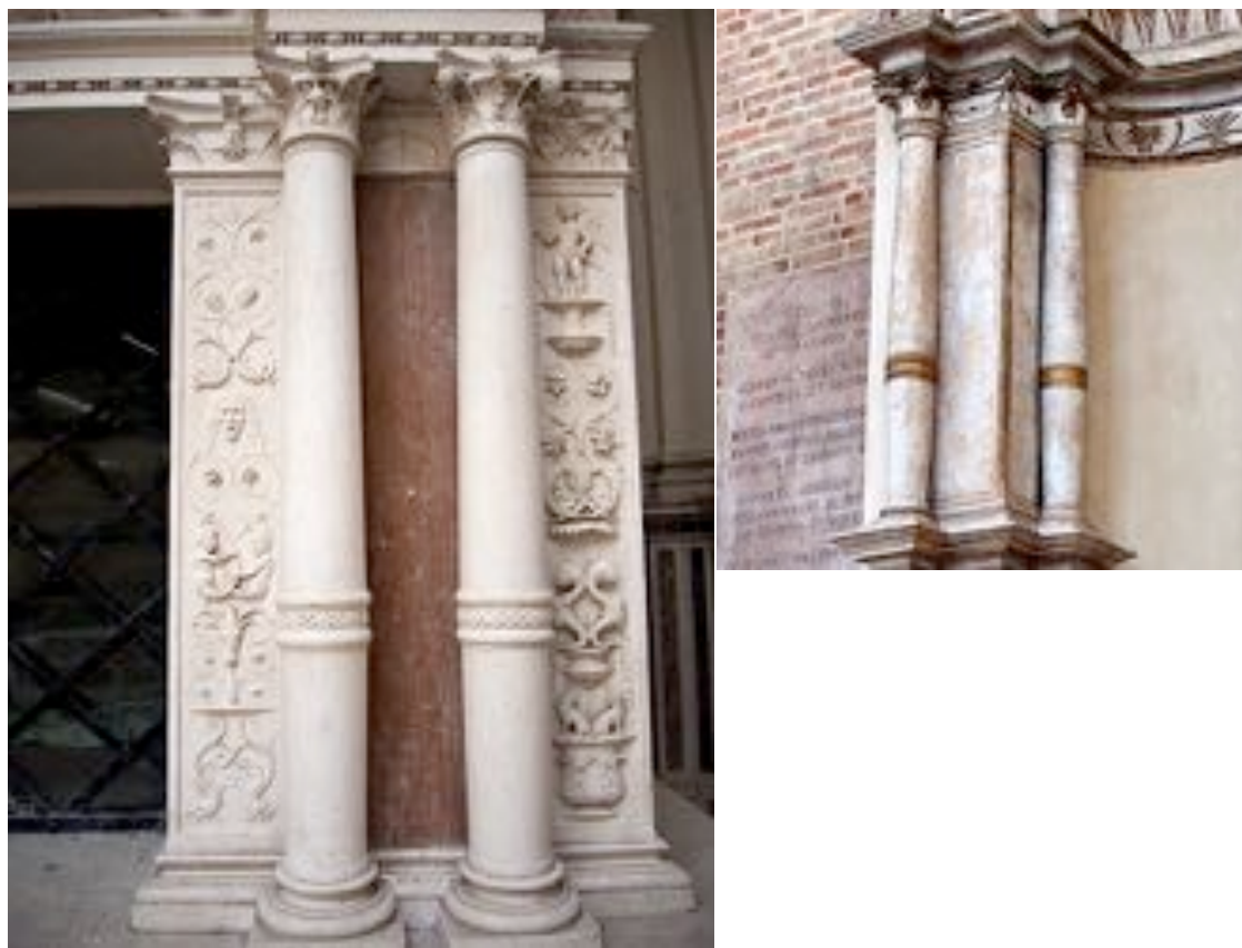
Fig. 369 Girolamo Pittoni, Mausoleo di San Pietro Celestino , L'Aquila, basilica di Santa Maria di Collemaggio, particolare
