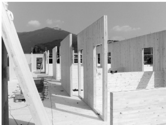
Fig. 3.2 Edificio in costruzione, tecnologia XLAM
