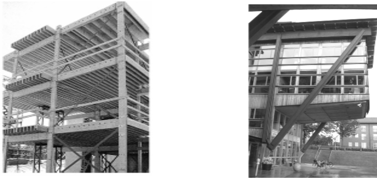
Fig. 3.4 Strutture in legno lamellare a telaio controventato
