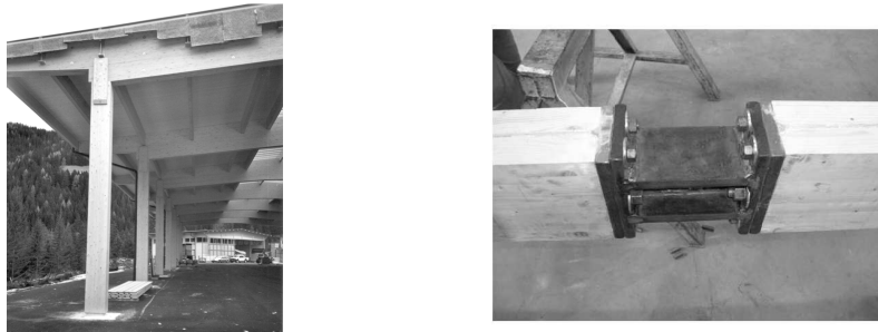
Fig. 3.7 Giunti a momento: a sinistra colonna incastrata alla base; a destra giunto di continuità
