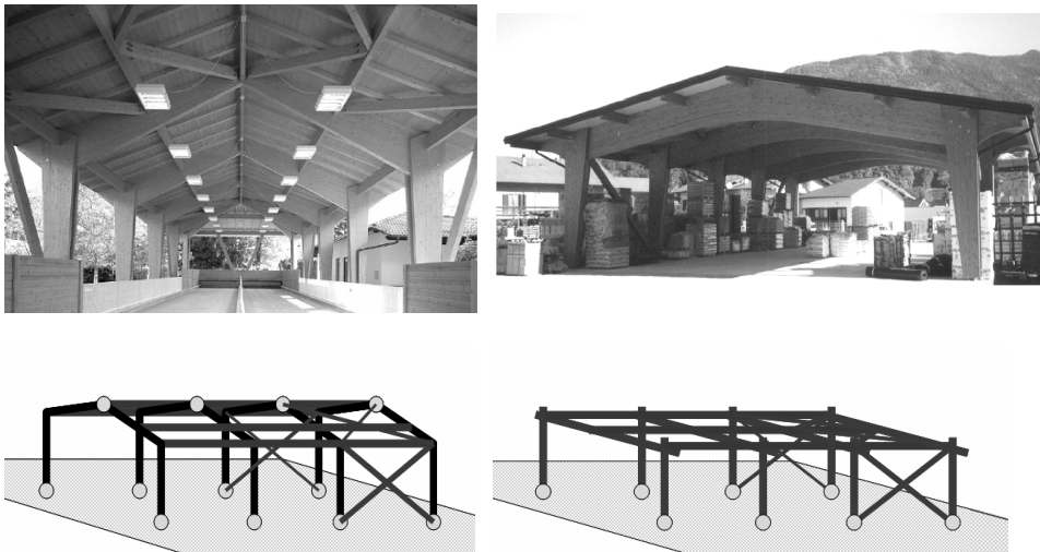
Fig. 3.5 Portali in legno lamellare: a sinistra arco a tre cerniere; a destra arco a due cerniere
