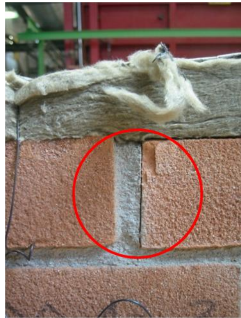
Fig. 54 Danneggiamento di un campione di muratura esposto a 300°C (secondo ciclo)
