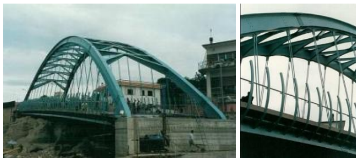
3. 59 Pozzuoli Bridge, Pozzuoli, Napoli, 1997, 58 m span, L. Romano, P. Pistoletti
