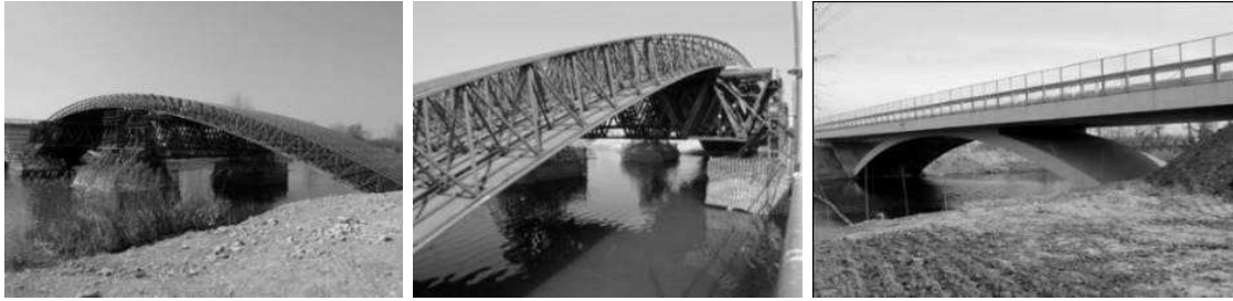
4. 69 Piave Vecchia Bridge, San Donà di Piave, Venezia, 2002, 45 m span, F. Zanchettin, E. Siviero
