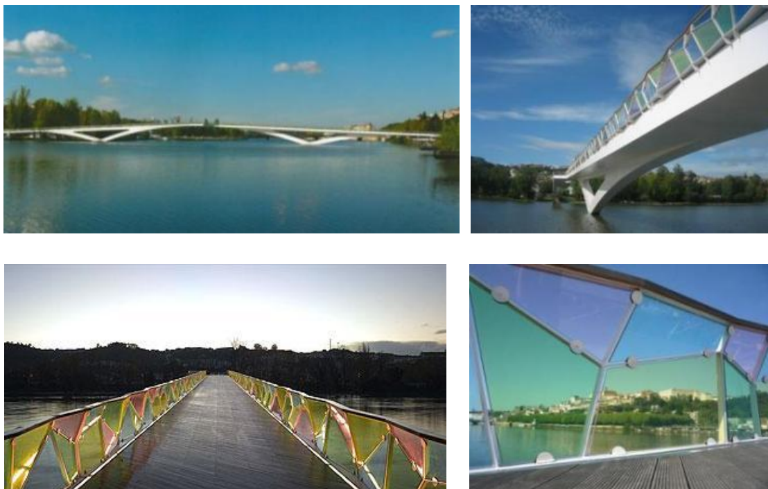
2. 29 Pedro and Inês Bridge, Coimbra, Portugal, 2006, 110 m span, A. Adão-da-Fonseca
