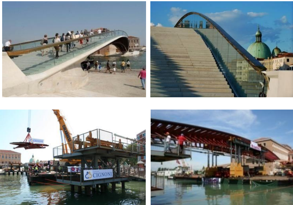
3. 66 Costituzione Bridge, Venezia, 2008, 80,8 m span, S. Calatrava
