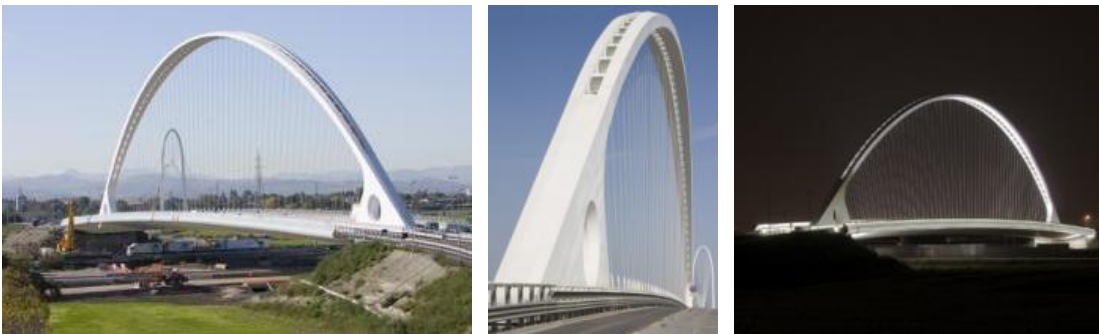
2. 25 Reggio Emilia Bridge, Reggio Emilia, Italia, 2007, 221 m span, S. Calatrava
