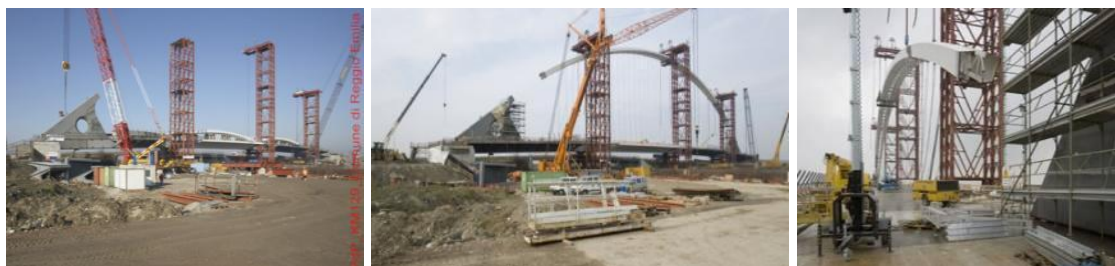
3. 65 Reggio Emilia Bridge, Reggio Emilia, 2000, 221 m span, S. Calatrava
