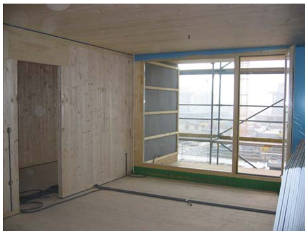
Figura 2.8. Edificio in costruzione, pareti massicce XLAM
