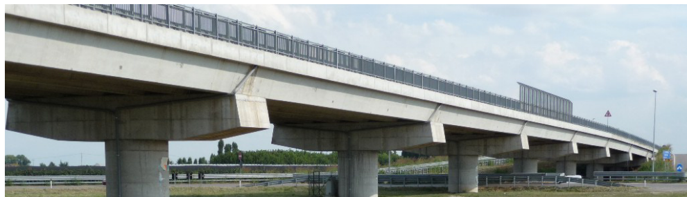
Fig. 18 Isola della Scala Bridge, Verona, Italy
