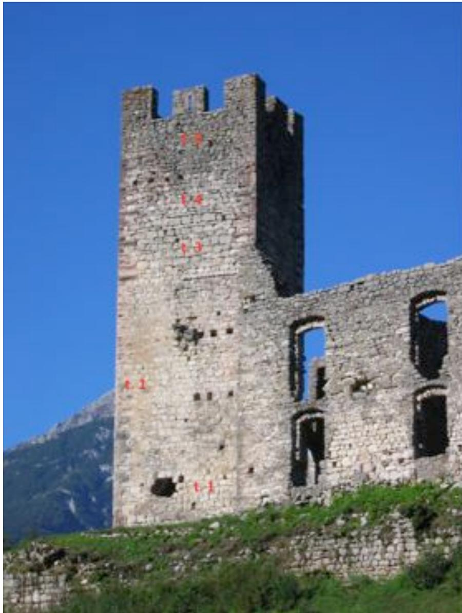
Figg. SC 12b-c – Muratura di cinta e lato est della torre (fasi costruttive).
