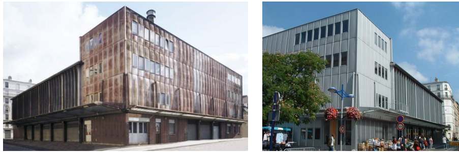
(a) Facade of the offices of the “Maison du peuple”, Clichy (F), 1939, Jean Prouvé. (b) Renovation of the Maison de Peuple, 1988.
