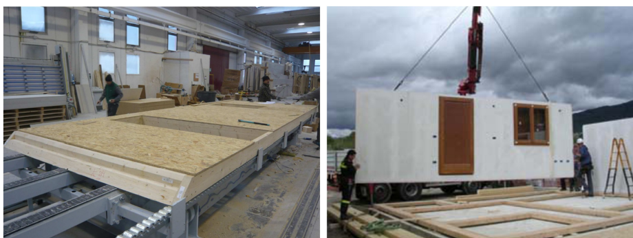
Figura 2.2: Prefabbricazione in stabilimento e montaggio in cantiere
