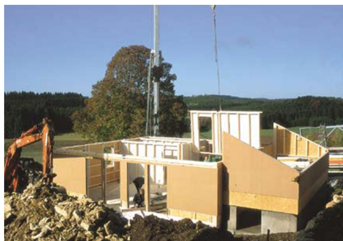
Figura 2.6: Disposizione pareti strutturali
