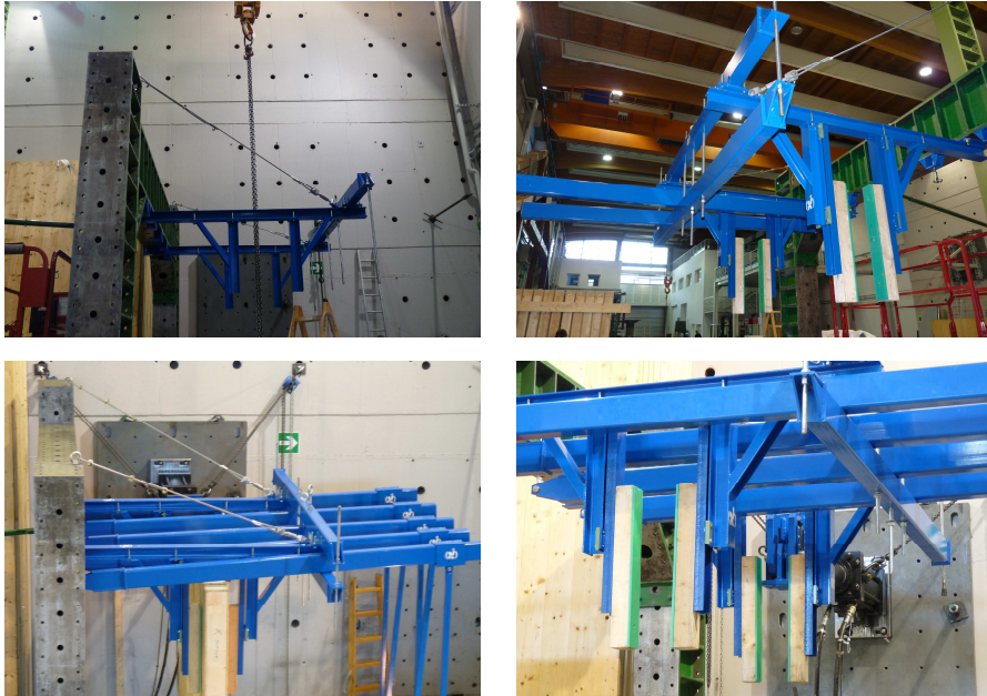
Figura 4.29: Fasi di montaggio dei ritegni torsionali
