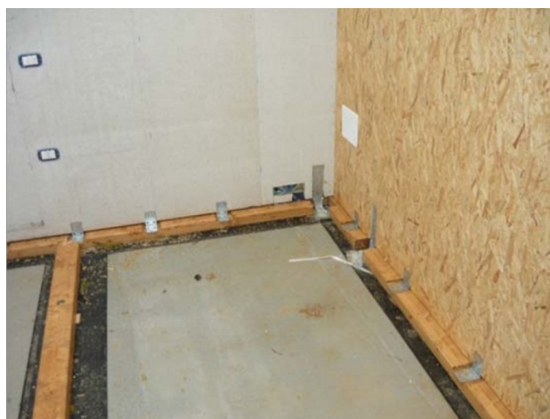
Figura 3.9: Elementi angolari per la stabilità a scorrimento e ribaltamento delle pareti a piano terra
