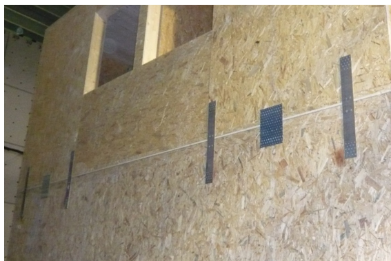
Figura 3.8: Elementi angolari per la stabilità a scorrimento e ribaltamento delle pareti superiori
