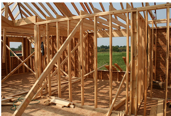
Figura 2.3: Costruzione in cantiere di un tipico edificio a pareti intelaiate nordamericano
