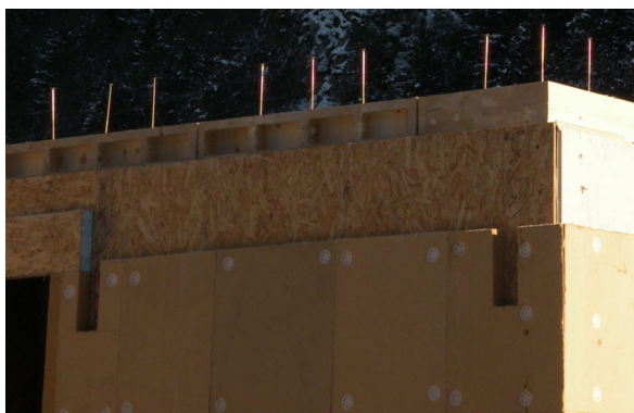
Figura 3.7: Collegamento pareti-solaio mediante viti da legno
